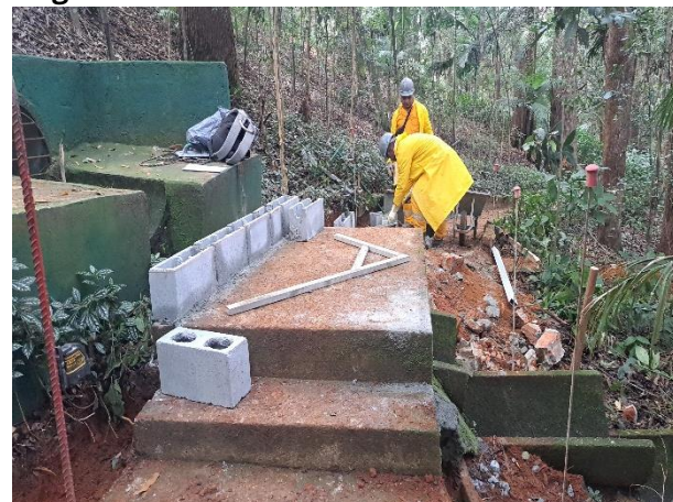
Figura 152: Reforma nas escadas das trilhas
