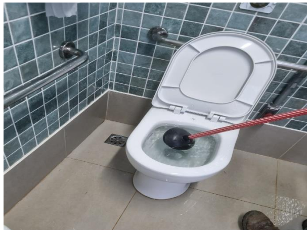
Figura 110: Desentupimento de vaso sanitário
