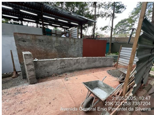
Figura 133: Construção de rampa acessível no setor administrativo
