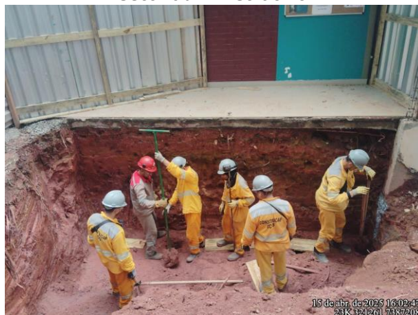
Figura 125: Construção de rampa acessível no setor administrativo
