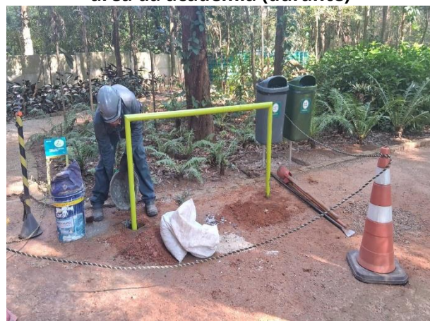
Figura 109: Implantação de barra de apoio na área da academia (depois)
