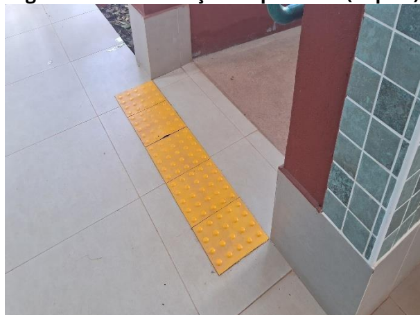
Figura 104: Recolocação de piso tátil (depois)
