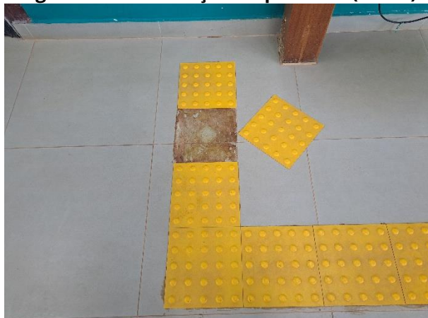
Figura 101: Recolocação de piso tátil (durante)
