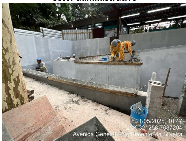
Figura 134: Construção de rampa acessível no setor administrativo
