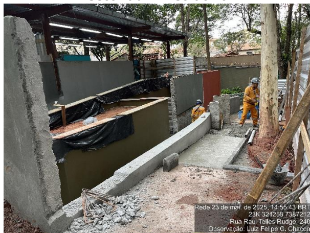
Figura 134: Construção de rampa acessível no setor administrativo
