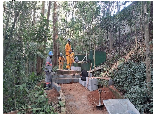
Figura 152: Reforma nas escadas das trilhas
