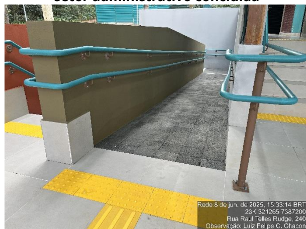
Figura 145: Construção da rampa acessível do setor administrativo concluída
