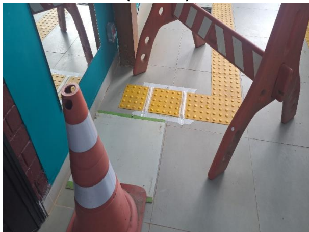
Figura 103: Recolocação de piso tátil (depois)
