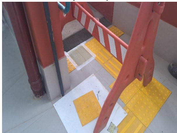
Figura 104: Recolocação de piso tátil (depois)
