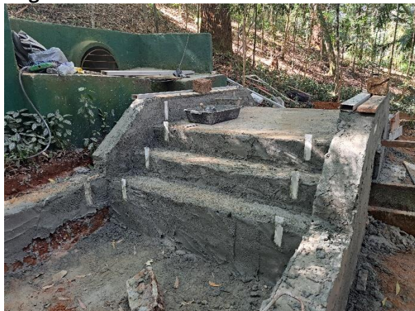
Figura 158: Reforma nas escadas das trilhas
