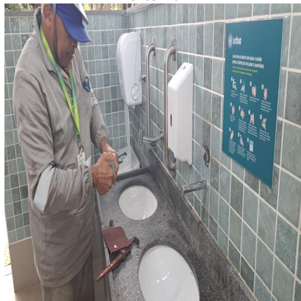
Figura 107: Implantação de barra de apoio na área da academia (durante)
