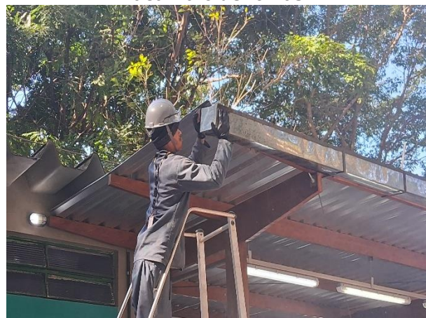
Figura 116: Limpeza e reparo das calhas com acúmulo de folhas
