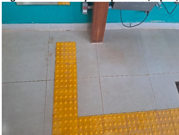
Figura 103: Recolocação de piso tátil (depois)
