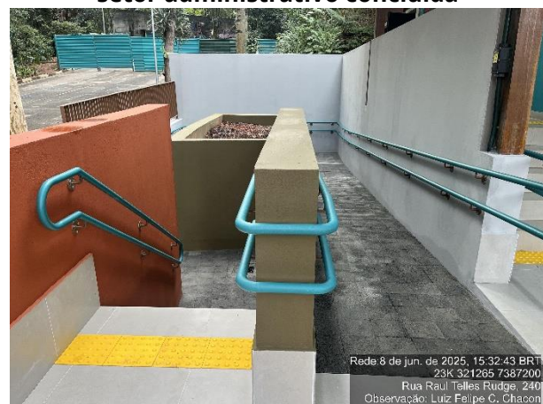
Figura 146: Construção da rampa acessível do setor administrativo concluída
