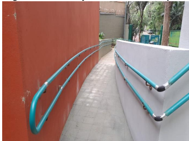
Figura 140: Construção da rampa acessível do setor administrativo concluída
