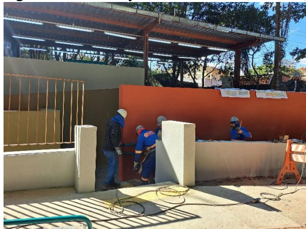
Figura 139: Pintura final na rampa acessível do setor administrativo
