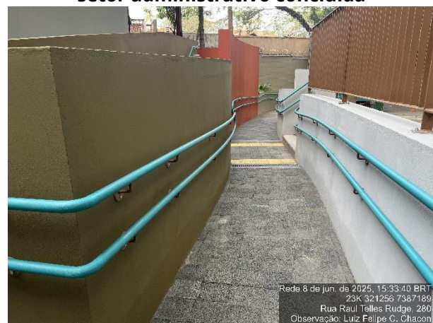
Figura 146: Construção da rampa acessível do setor administrativo concluída
