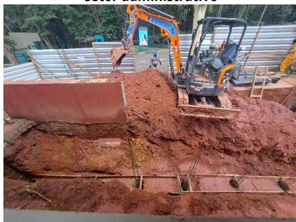
Figura 127: Construção de rampa acessível no setor administrativo
