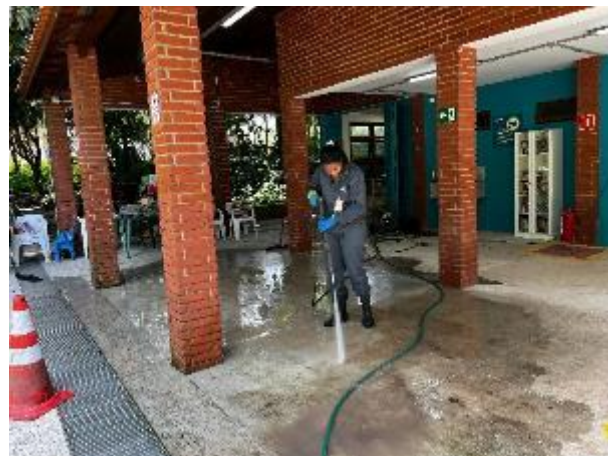
Figura 84: Limpeza com WAP na área multiuso (antes)
