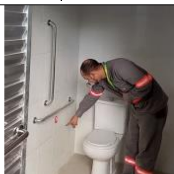
FIGURA 251: REPARO DE ALARME PCD WC MASCULINO
