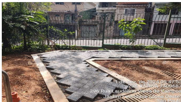
Figura 269 construção de rampa acessível
