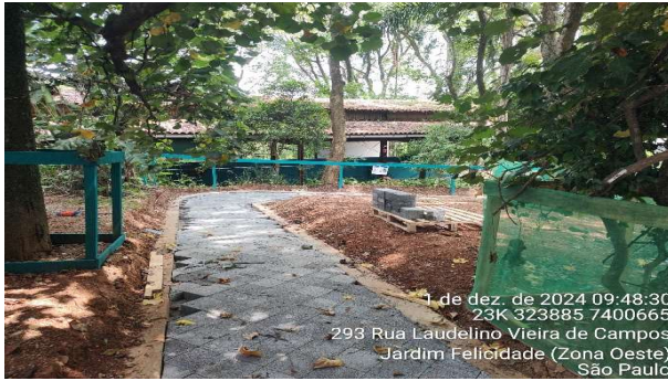
Figura 271 construção de rampa acessível
