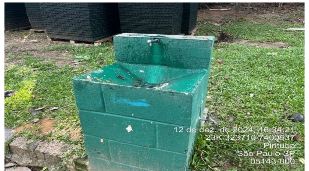
Figura 222 manutenção de vazamento no bebedouro do parque
