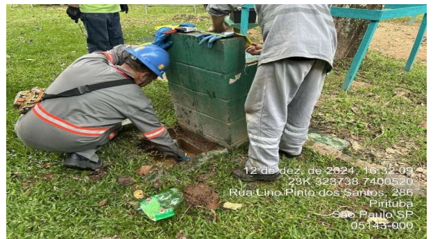
Figura 222 manutenção de vazamento no bebedouro do parque
