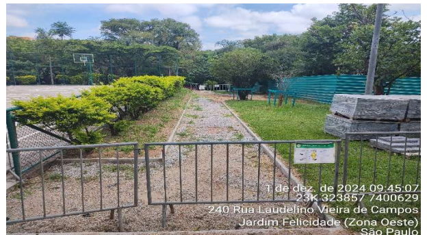
Figura 262 construção do piso drenante ao lado das quadras
