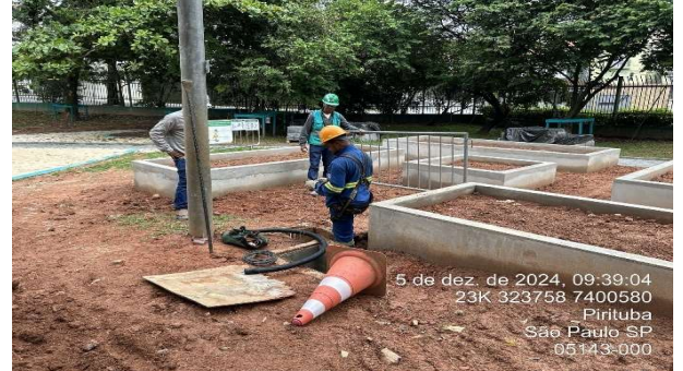
Figura 210 fabricação e troca da caixa de passagem no parquinho
