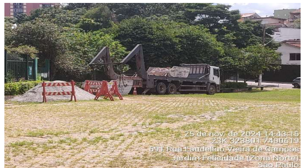
Figura 262 construção do piso drenante ao lado das quadras
