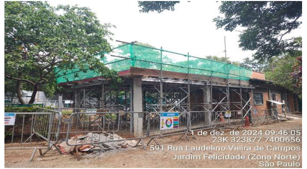
Figura 264 reforma do prédio administrativo
