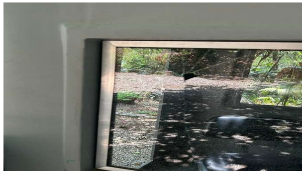
Figura 315 troca de vidro quebrado da guarita - durante
