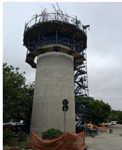
Concretagem com formas deslizantes, armaduras e concreto.
