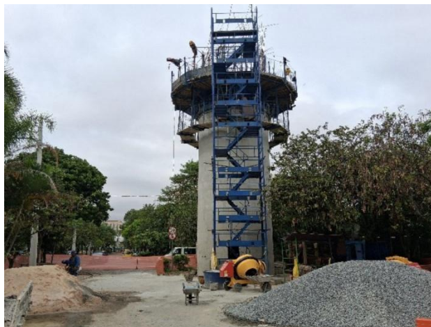
Concretagem com formas deslizantes, armaduras e concreto.
