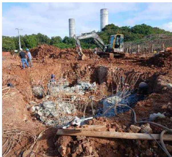
Arrasamento de estacas.
