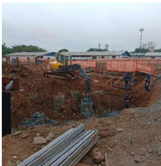
Escavação de estacas.
