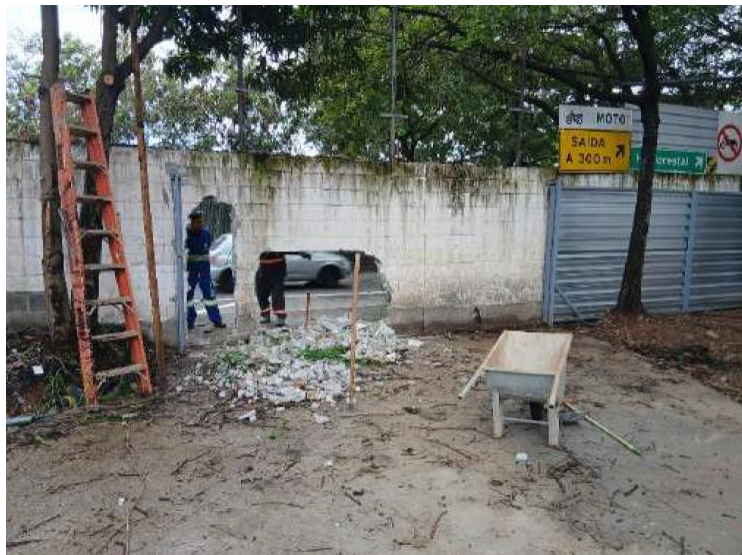
Demolição de muro existente guarita.
