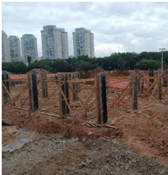
Montagem de formas dos pilares.
