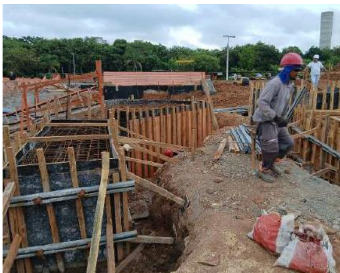
Montagem das Formas dos Blocos.
