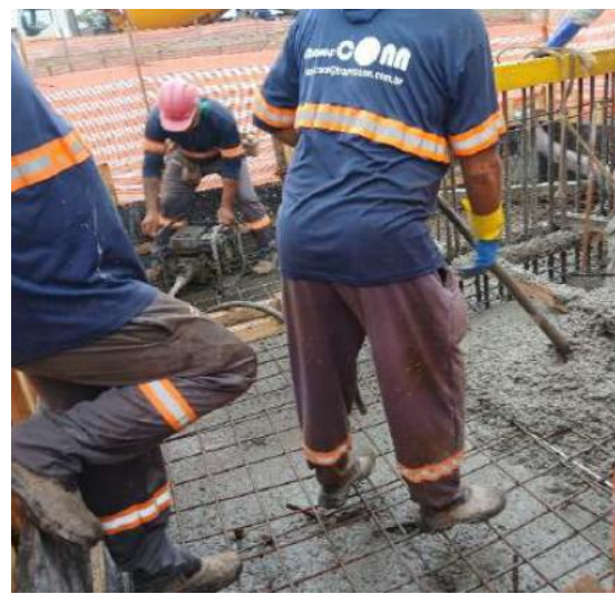
Concretagem dos blocos.
