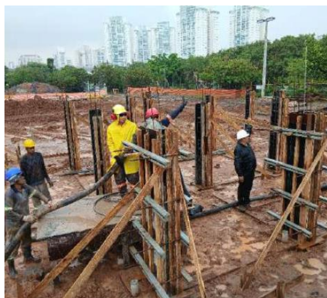
Concretagem de pilares.
