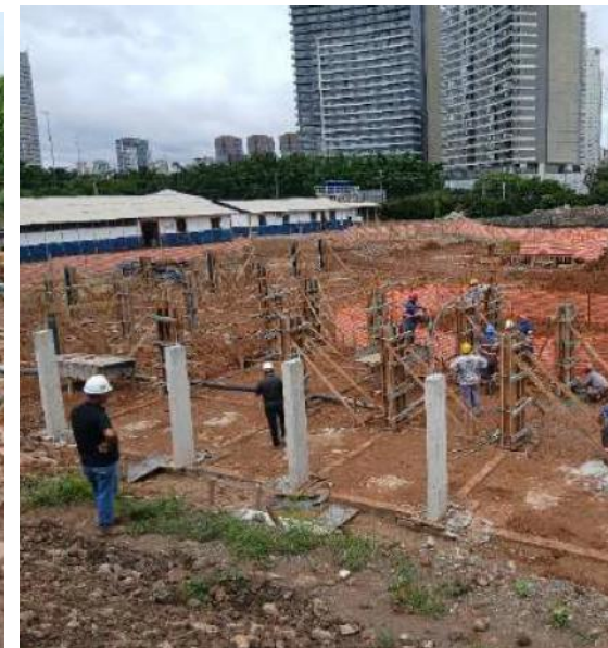
Desforma de pilares.
