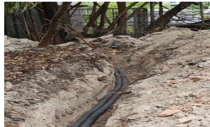
2 – Vala com instalação da tubulação da rede elétrica
