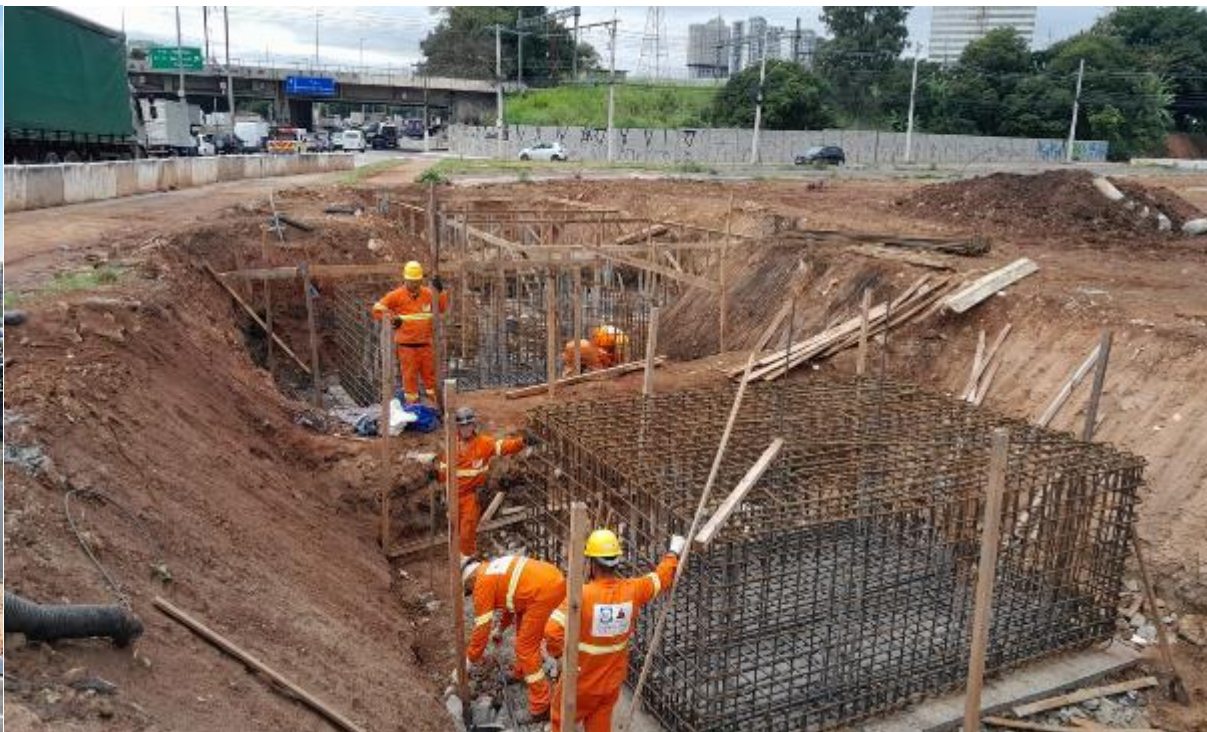
Montagem das armaduras dos blocos AP5
