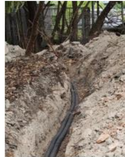
Passagem de eletrodutos.
