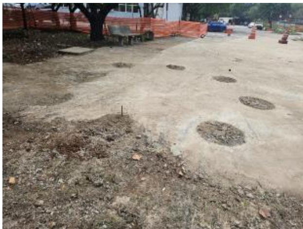
Concretagem da base da caixa d'água.
