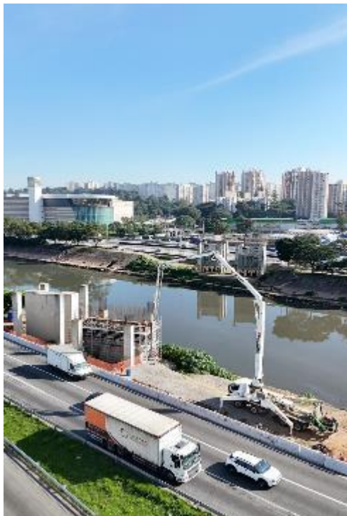
Concretagem do AP4
